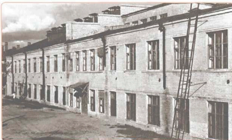
Корпус № 1 для выращивания цыплят в батареях
