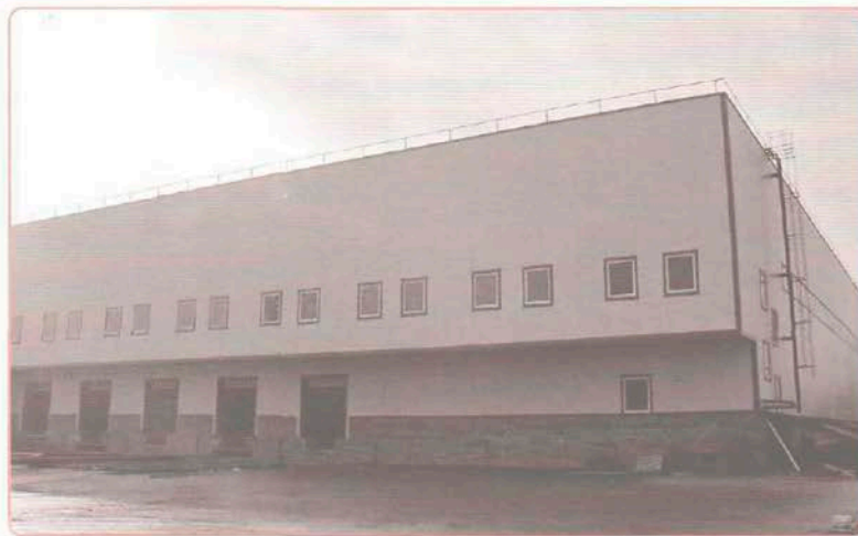
Новый складской терминал
