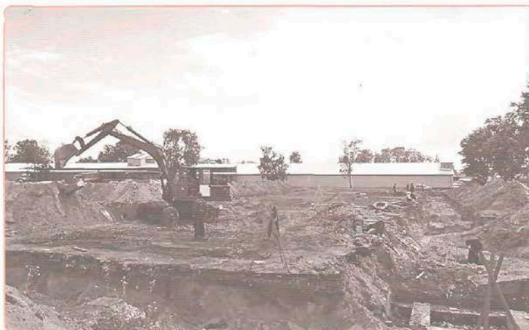
Строительство нового склада
