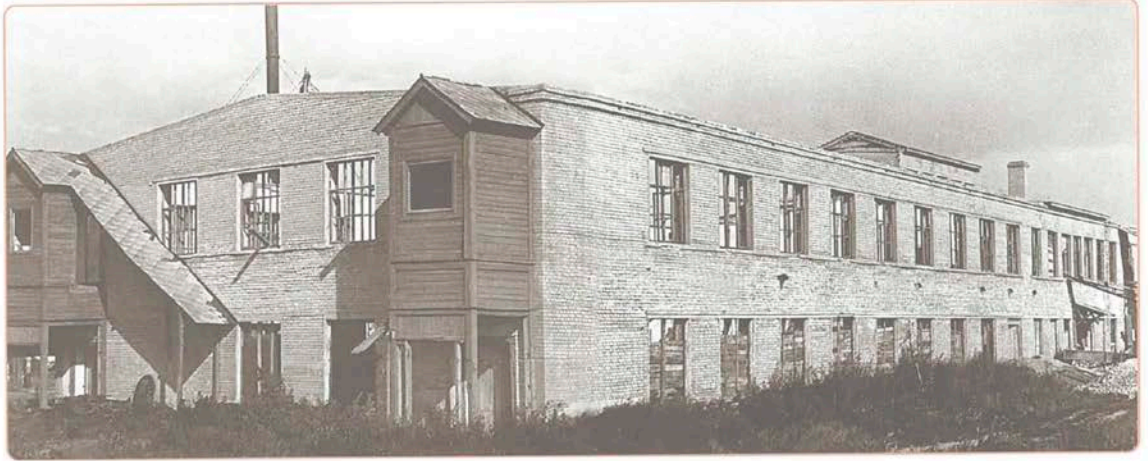
Корпус № 3 до восстановления
