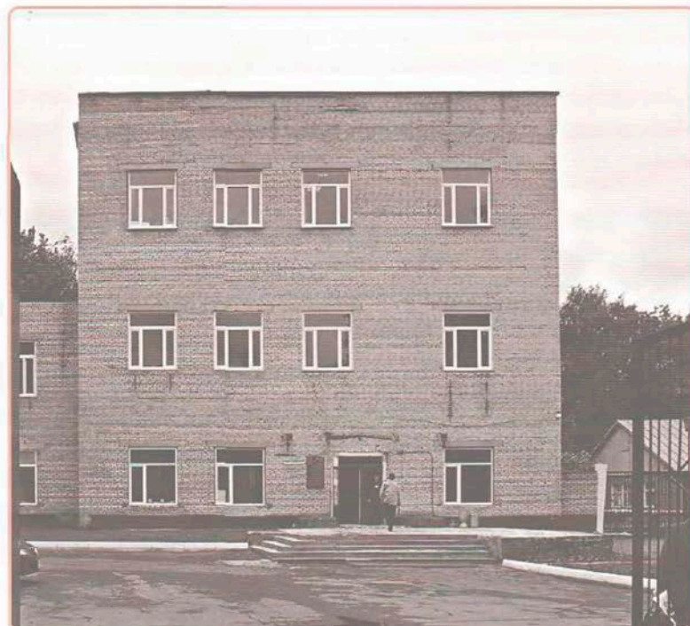
Здание управляющей компании
