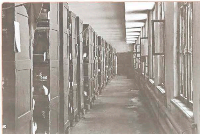
Зал корпуса № 1 для выращивания цыплят в батареях
