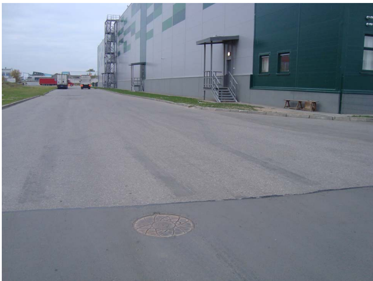
Участок :203. Колодец с запорной арматурой пожарного водопровода
