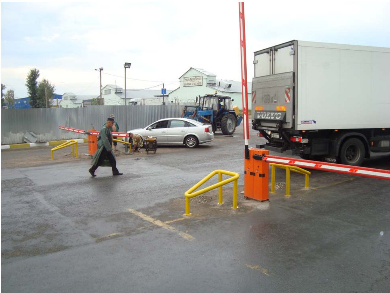
КПП №5. Монтаж колесоотбойников перед шлагбаумами и мачты освещения с LED светильником
