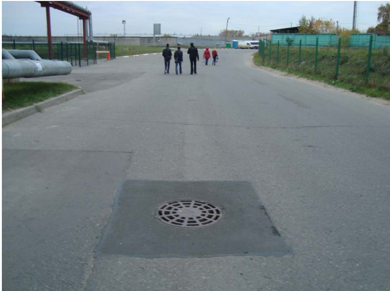
Участок :210. Колодец ливнестока. Ремонтные работы завершены
