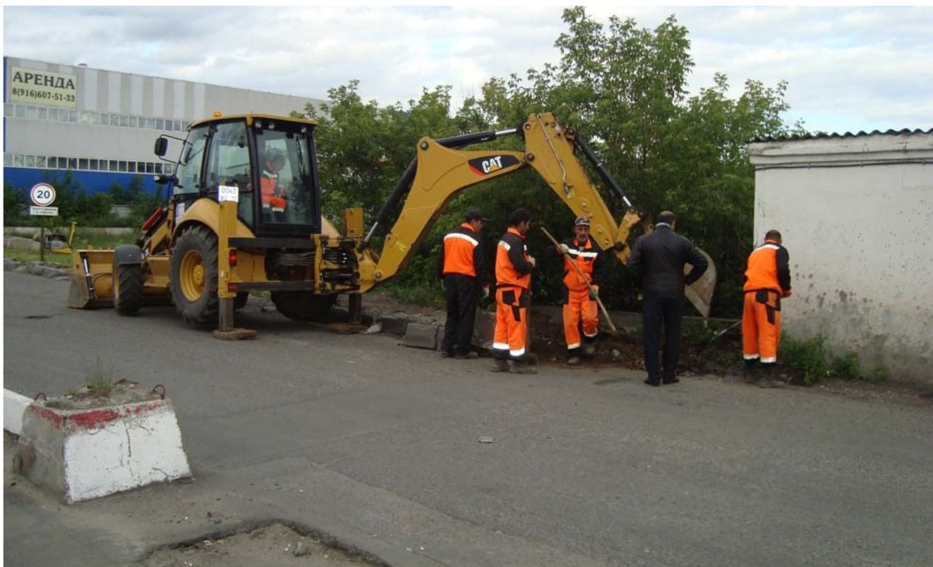
Участок :230. КПП №6. Работы по подготовке поверхности под расширение и асфальтирование
