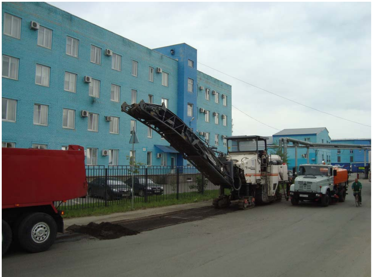
Участок :287. Начало работ по расширению. Выполняется фрезерование поверхности.
