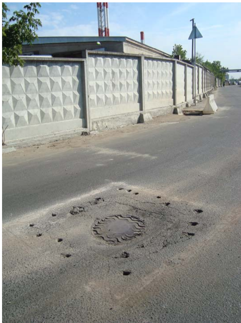
Участок :229. Работы по реконструкции трех аварийных люков на повороте
