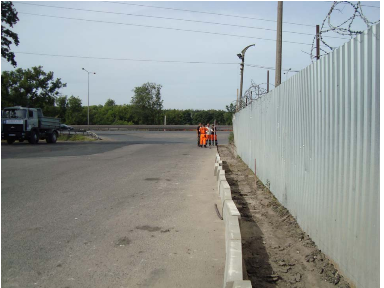
Участок :242. Монтаж бордюрного камня по всей длине дороги.
