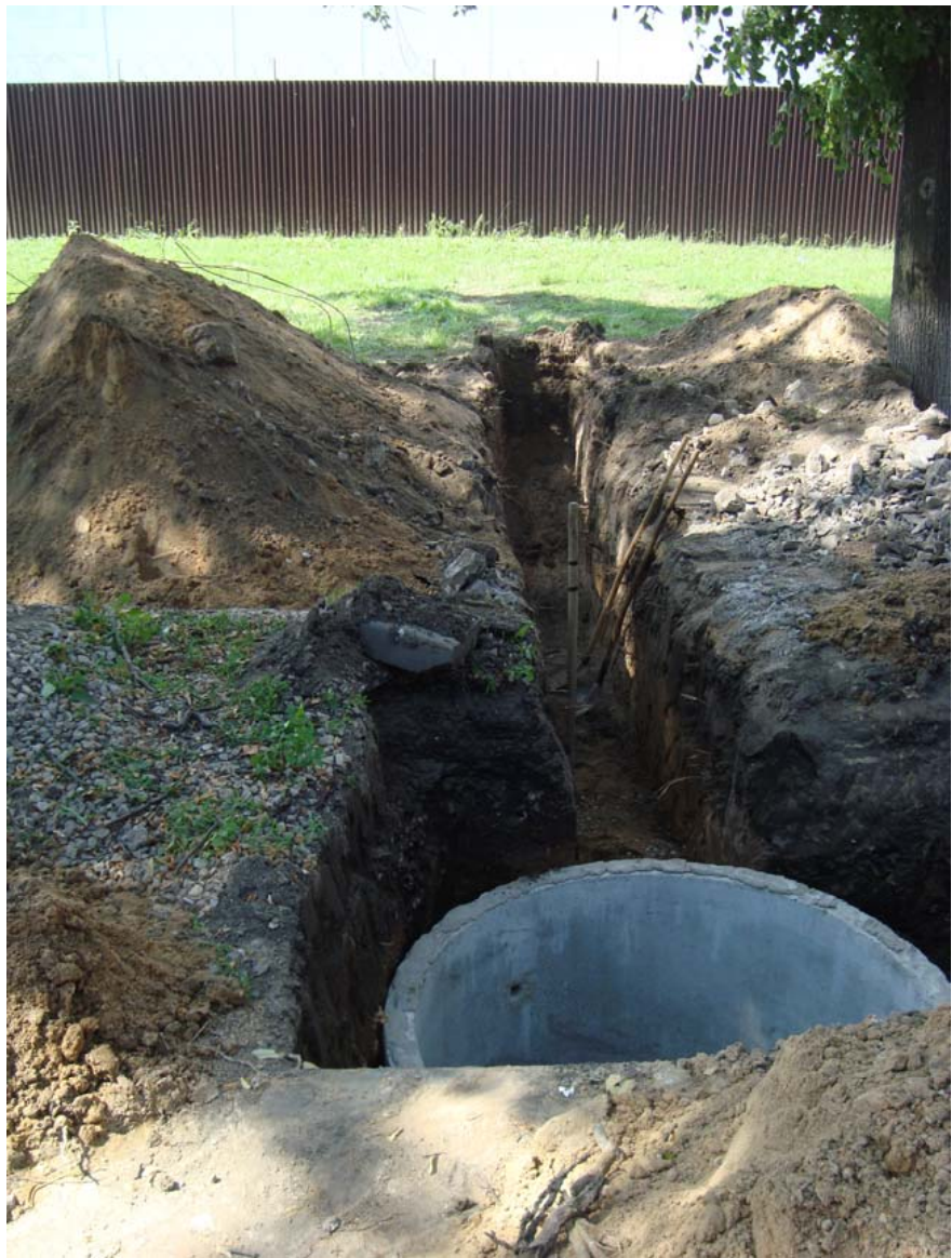
17.07.2014г. Производство работ. Разработка траншеи трубопровода ливнестока
