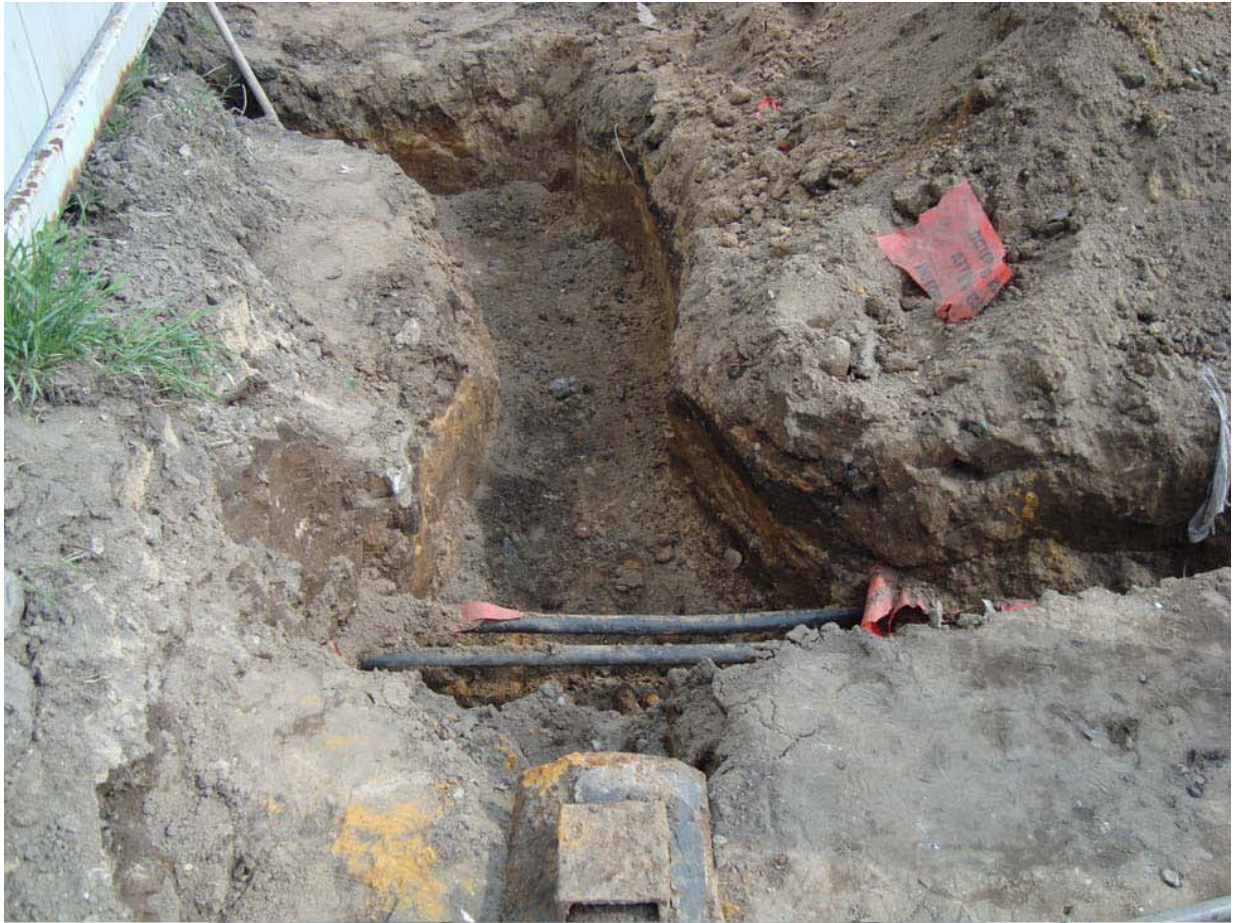
КПП №6 работы по перекладке кабелей и переносу щитовой
