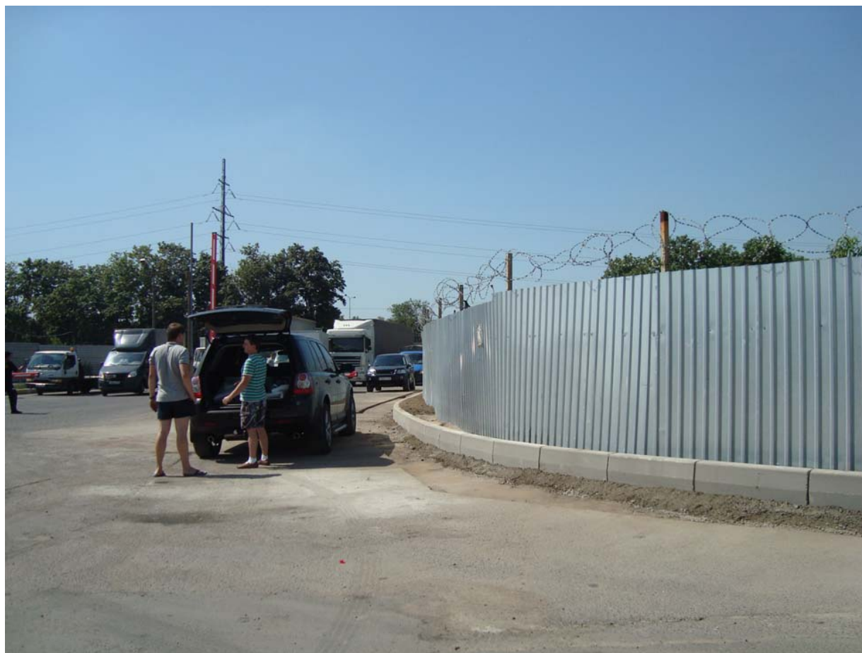
Участок :242. Монтаж бордюрного камня по всей длине дороги. Выполнение плавного закругления.
