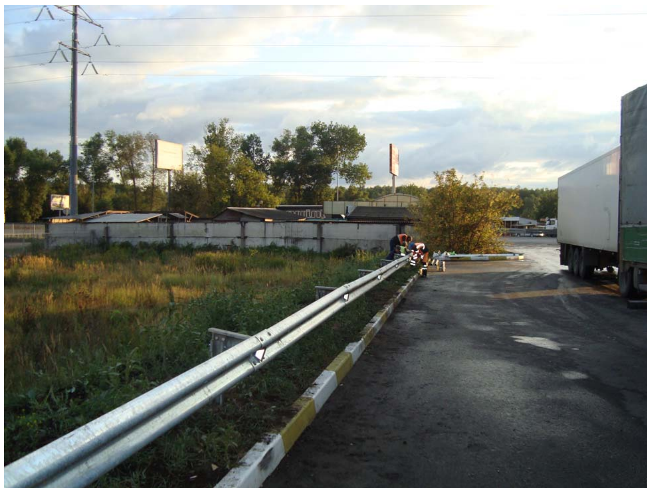
Участок :230. КПП №6. Выполняются работы по устройству магистрального отбойника
