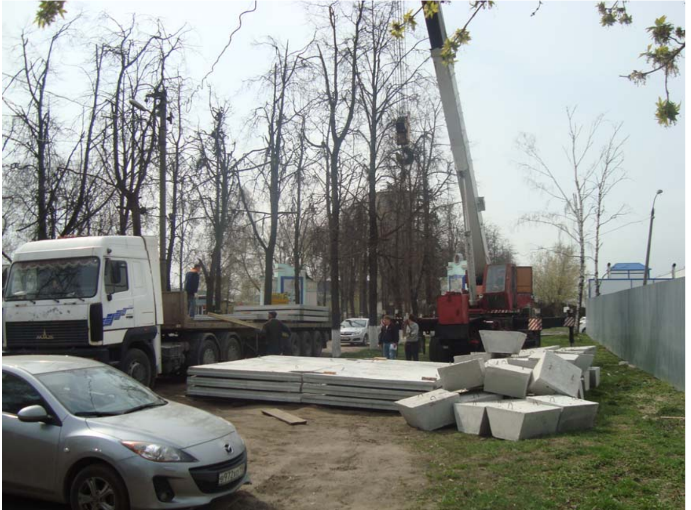
Разгрузка железобетонных панелей и фундаментов будущего забора.
