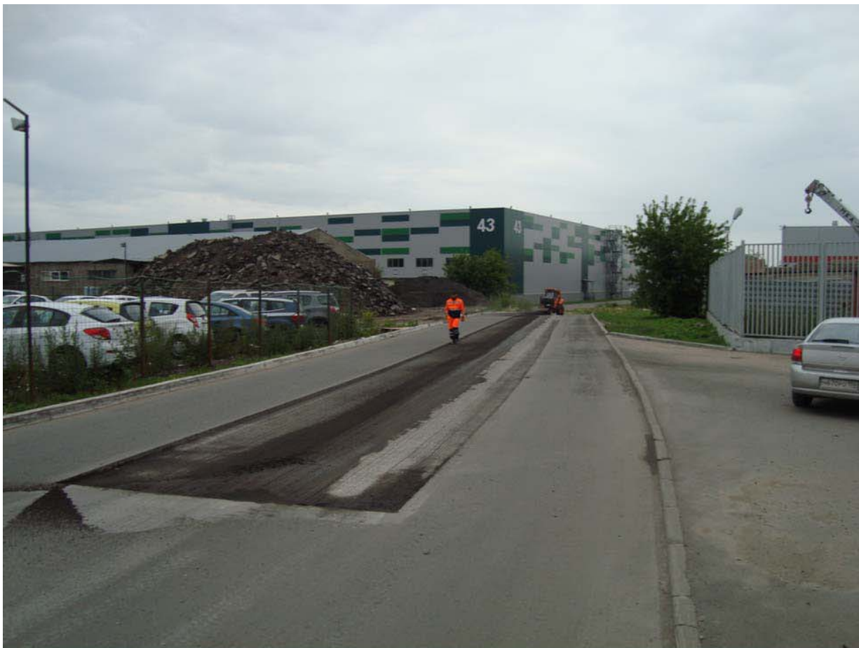
Участок :226. Работы по ликвидации долевой трещины. разделка асфальта путем фрезерования
