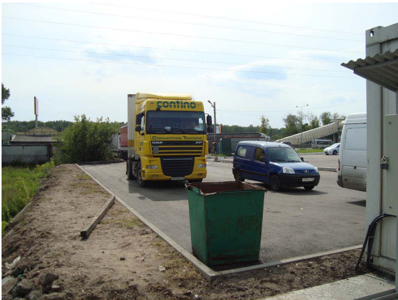
Участок :230. КПП №6. Выполнены работы по устройству бордюров и асфальтирование
