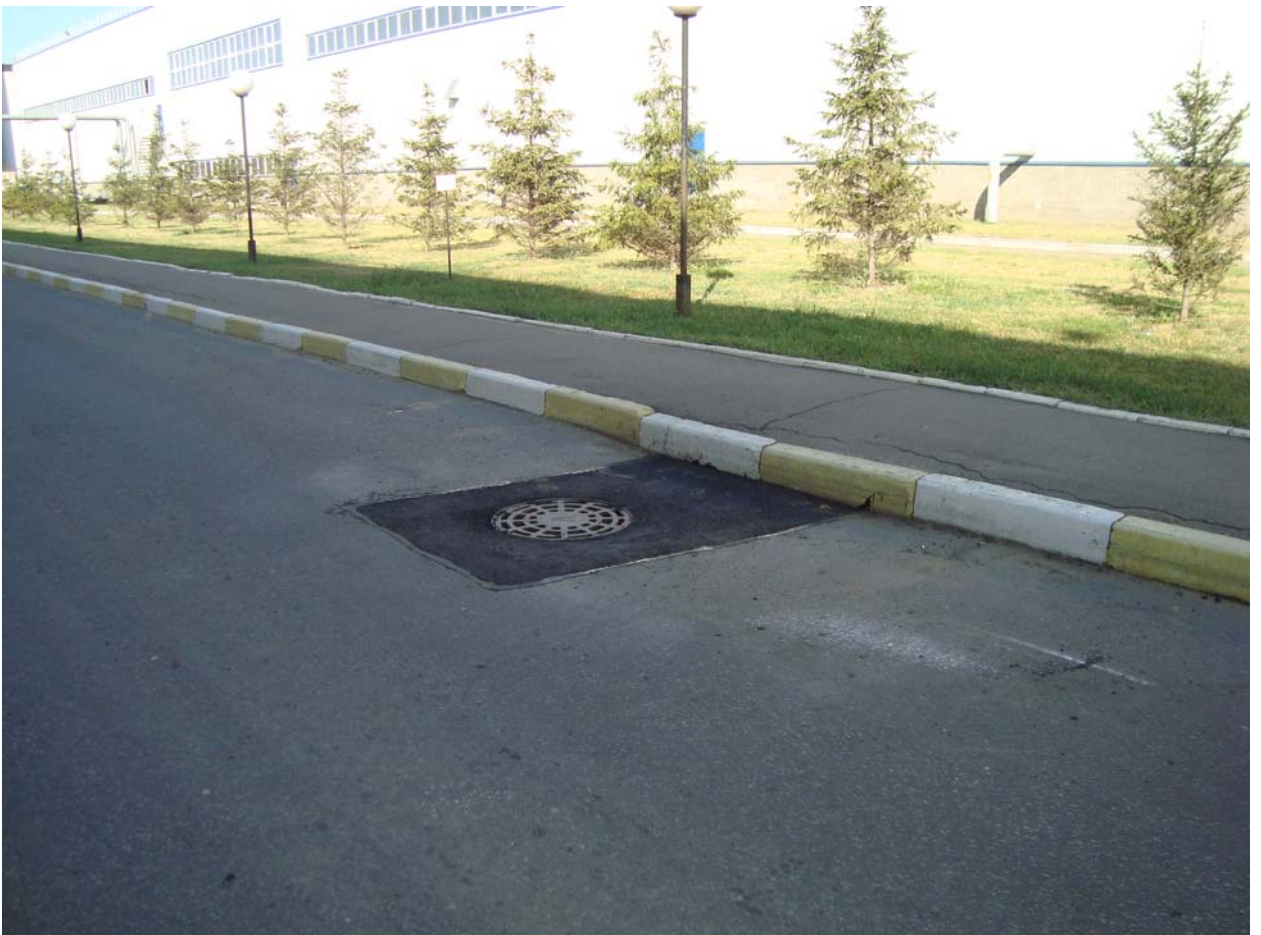
Участок :177. Дождеприемный колодец. Ремонтные работы завершены, колодец очищен и реконструирован.
