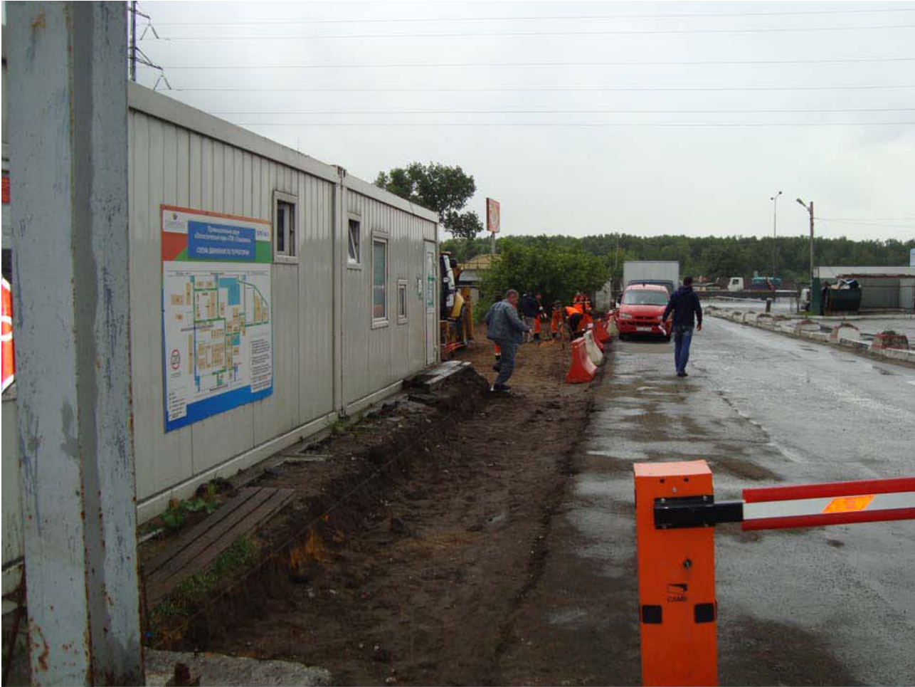
Участок :230. КПП №6. Работы по подготовке поверхности под расширение и асфальтирование
