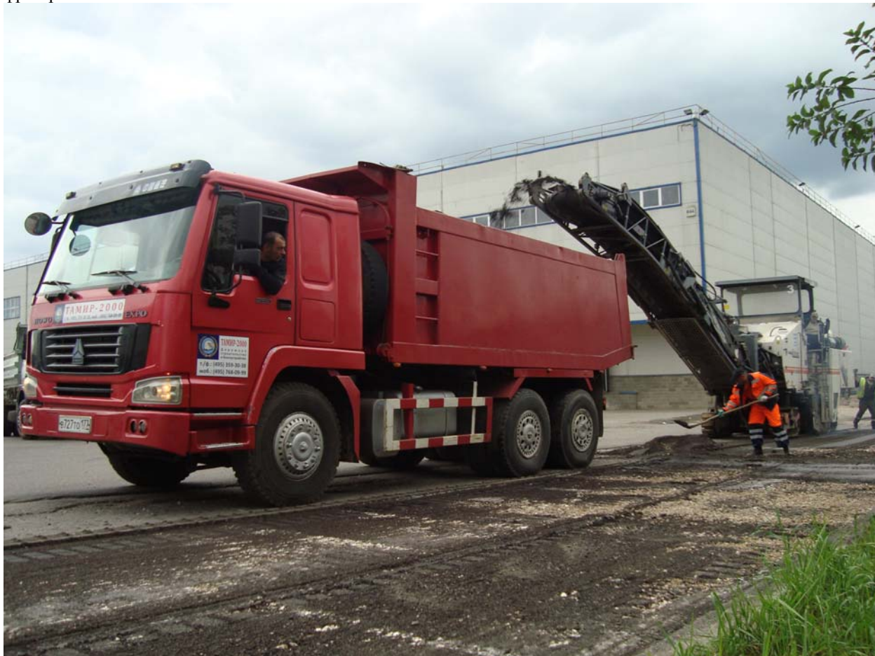
Участок: 203. Подготовка поверхности под асфальтирование: выравнивание нижнего слоя путем фрезерования
