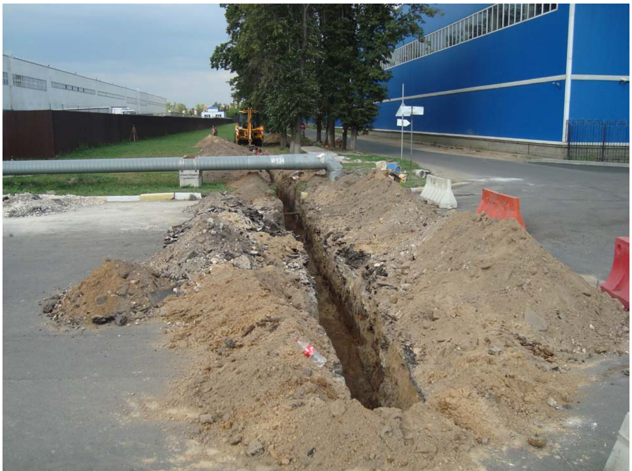
17.07.2014г. Производство работ. Разработка траншеи трубопровода ливнестока
