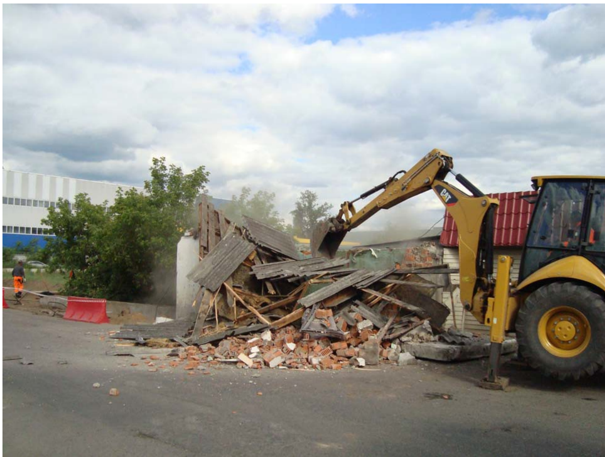
КПП №6. Вид со стороны Новорязанского ш. Демонтаж аварийного здания щитовой.
