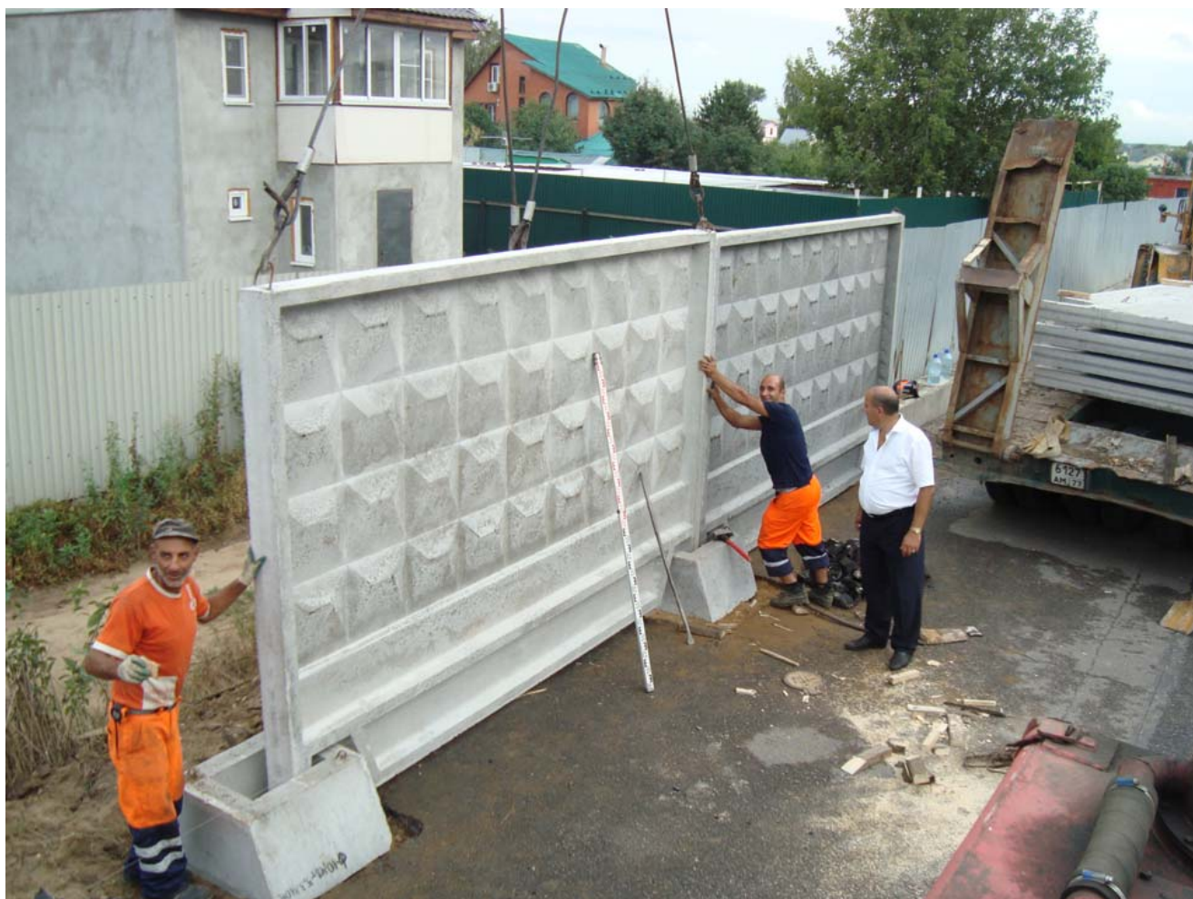
Участок :210 и :213 начаты работы по монтажу нового капитального забора.
