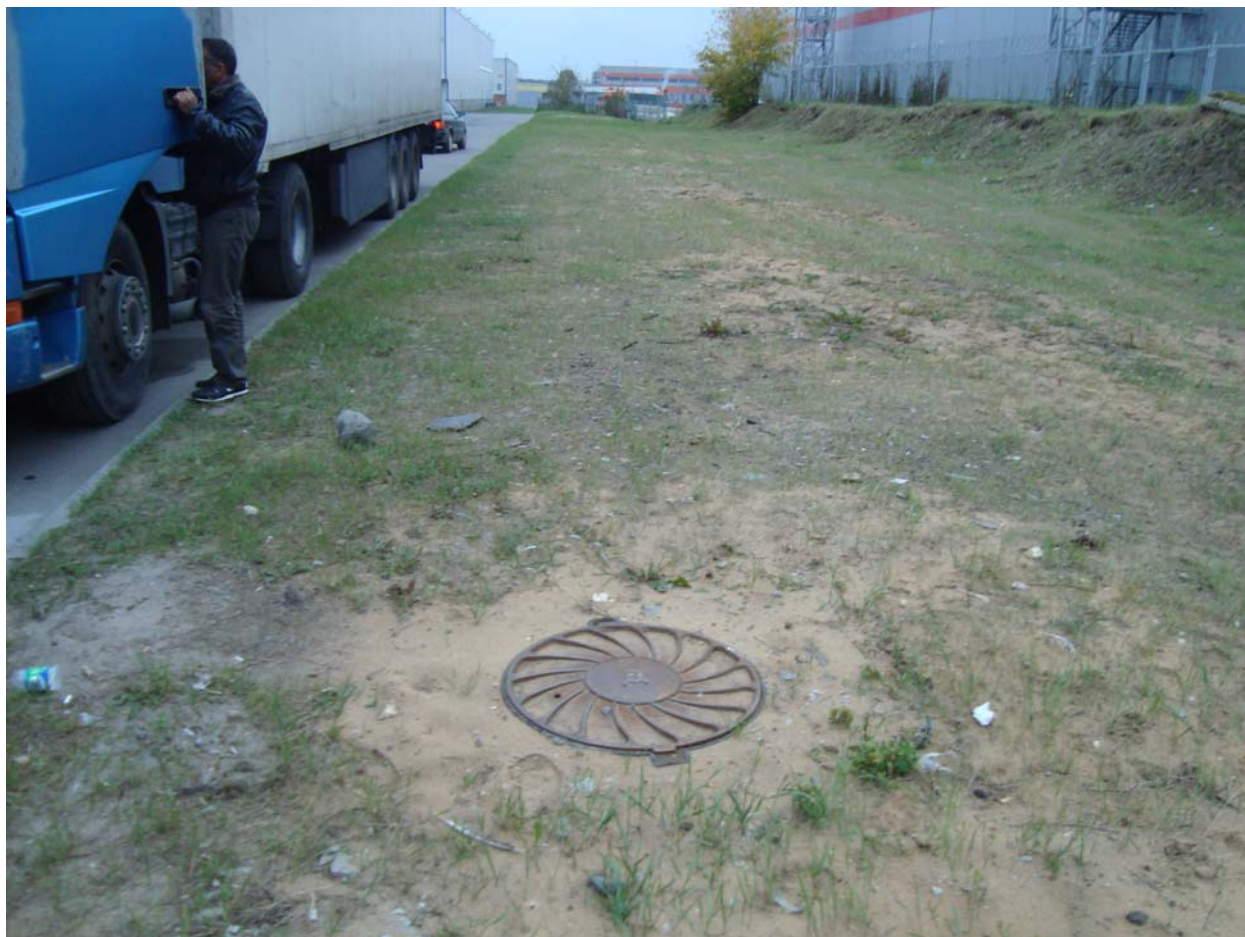
Участок :202. Колодец магистрали ливнеотока
