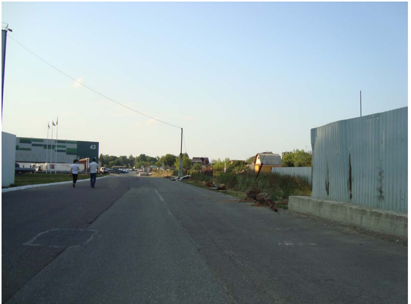
Участок :210 и :213 начаты работы по демонтажу старого аварийного забора.
