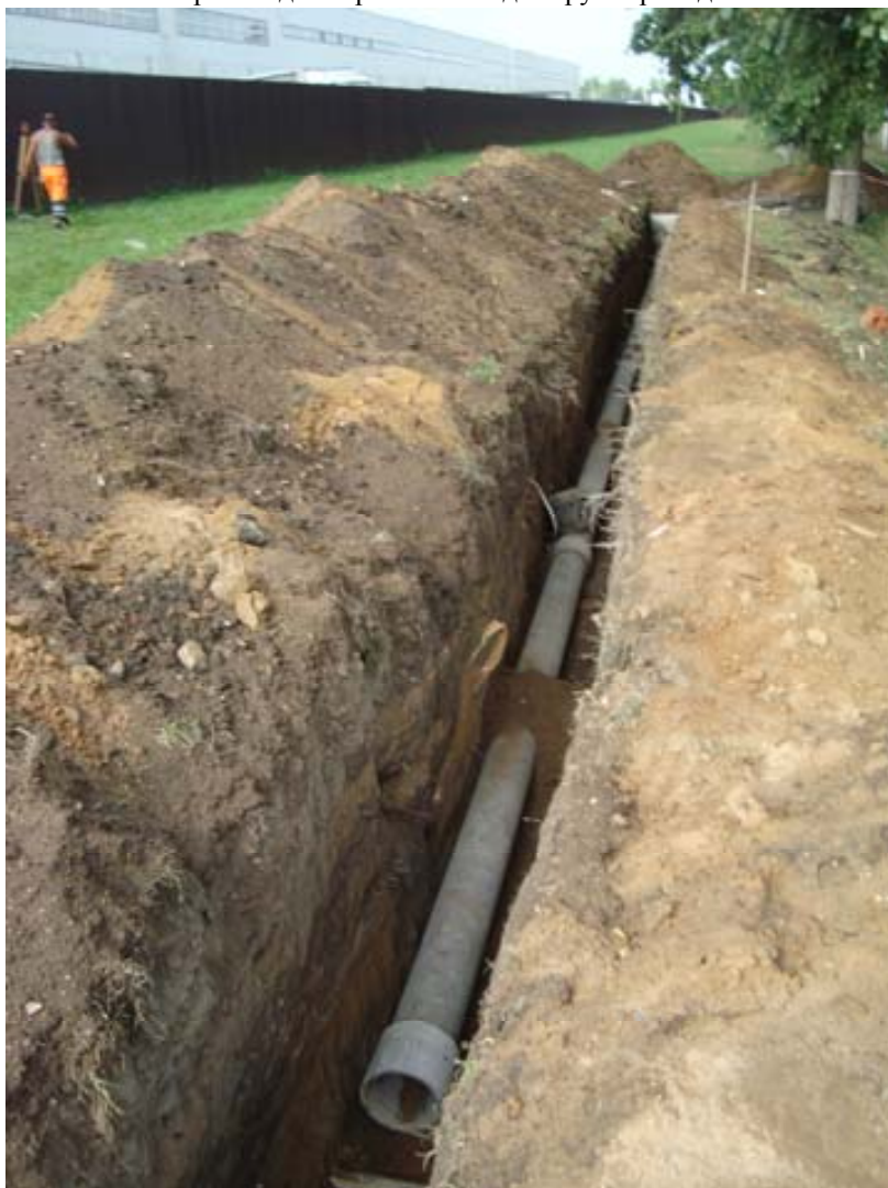
17.07.2014г. Производство работ. Устройство колодцев ливнестока
