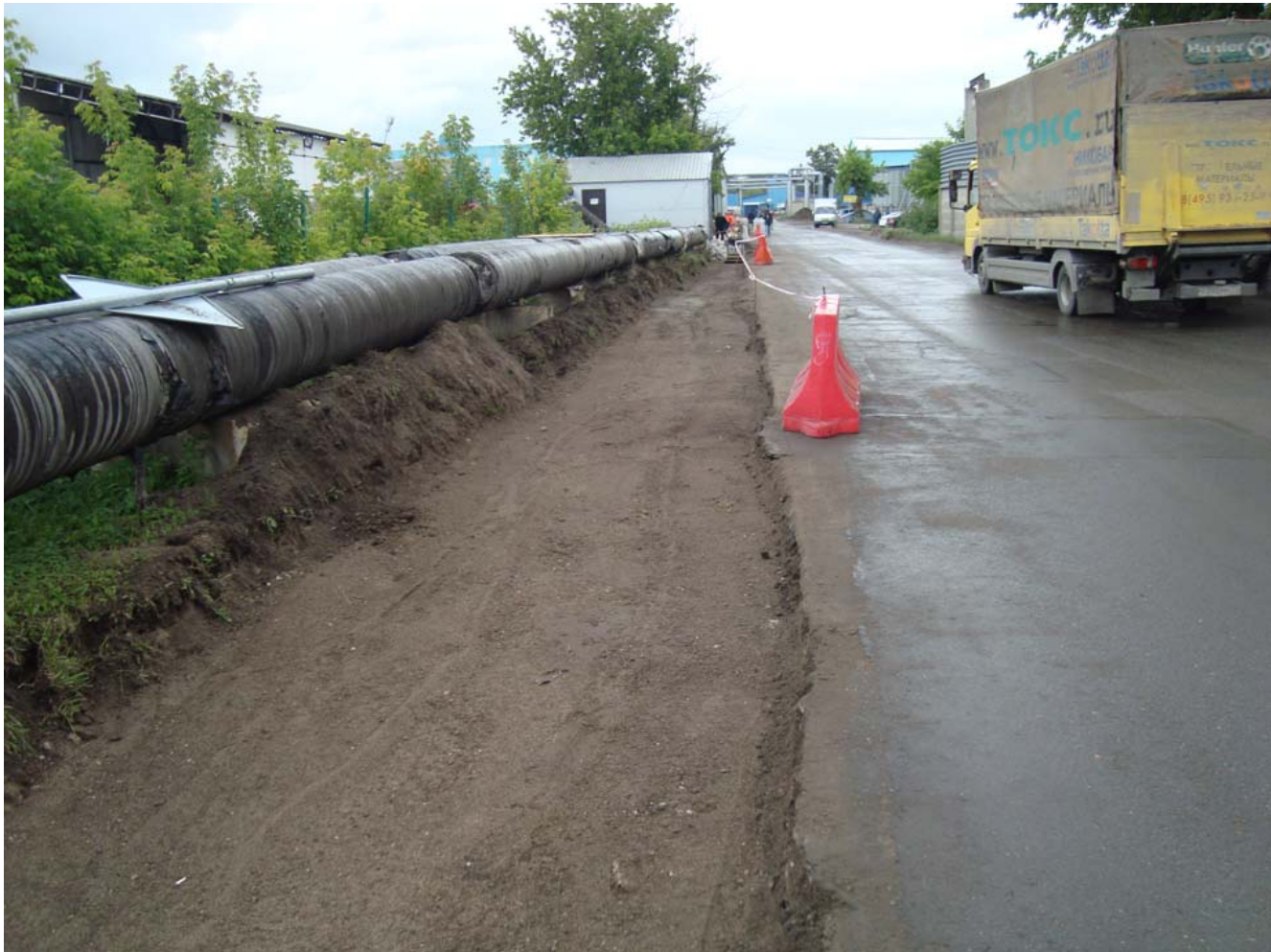
Участок :241. Работы по расширению полотна дороги. Устройство бордюрного камня.
