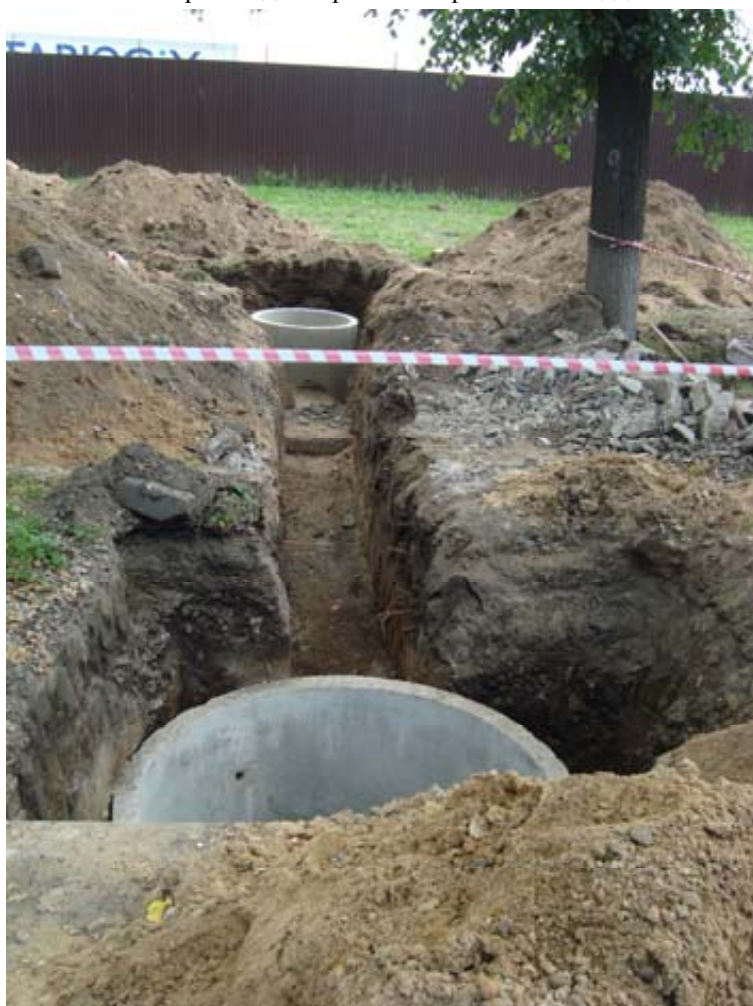
17.07.2014г. Производство работ. Устройство колодцев ливнестока
